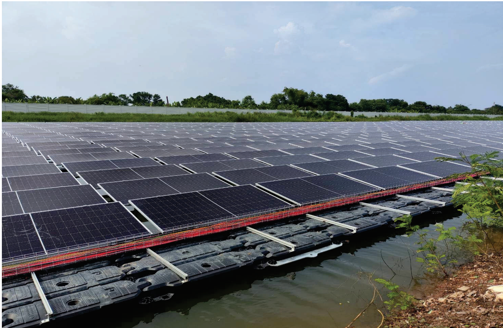
รูปที่ 2.4.2-3 ตัวอย่างภาพถ่ายการติดตั้งแผงเซลล์แสงอาทิตย์ชนิดติดตั้งบนทุ่นลอยน้ำบริเวณบ่อหน่วงน้ำ 1
