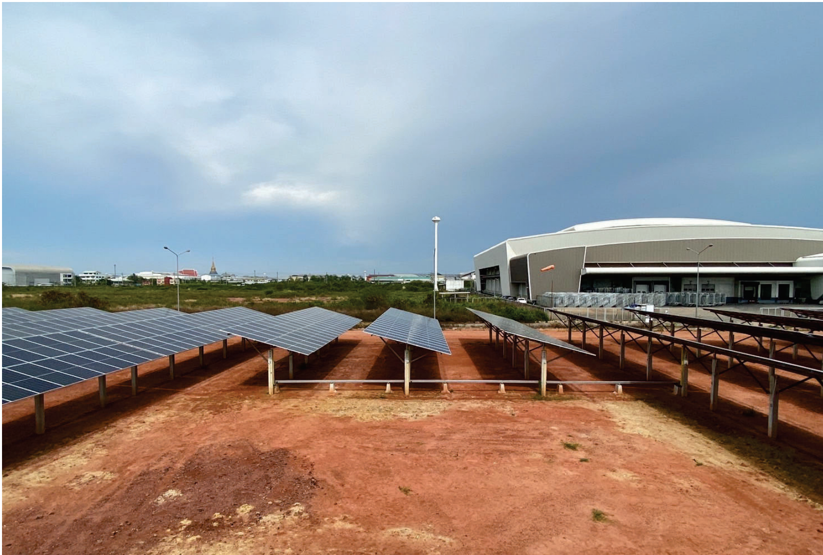
รูปที่ 2.4.2-4 ตัวอย่างภาพถ่ายการติดตั้งแผงเซลล์แสงอาทิตย์ชนิดติดตั้งบนพื้นดิน
