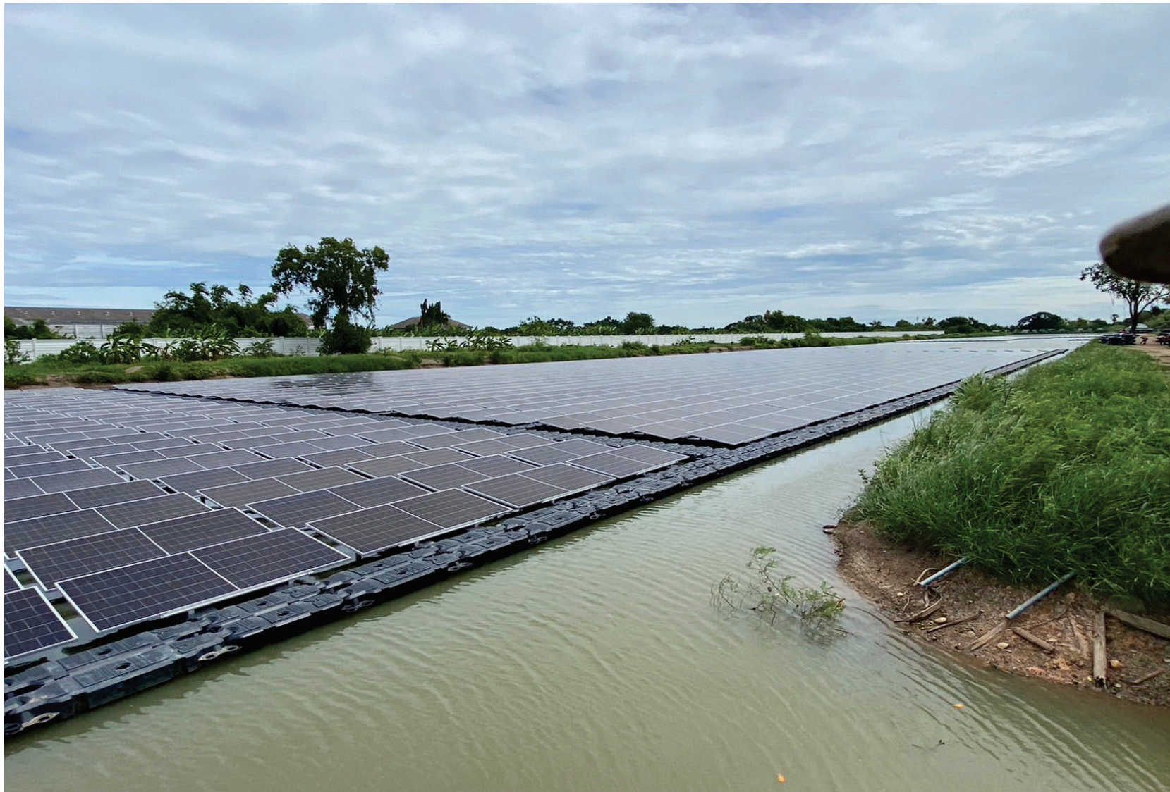
รูปที่ 2.4.2-3 (ต่อ) ตัวอย่างภาพถ่ายการติดตั้งแผงเซลล์แสงอาทิตย์ชนิดติดตั้งบนทุ่นลอยน้ำบริเวณบ่อหนองน้ำ 1
